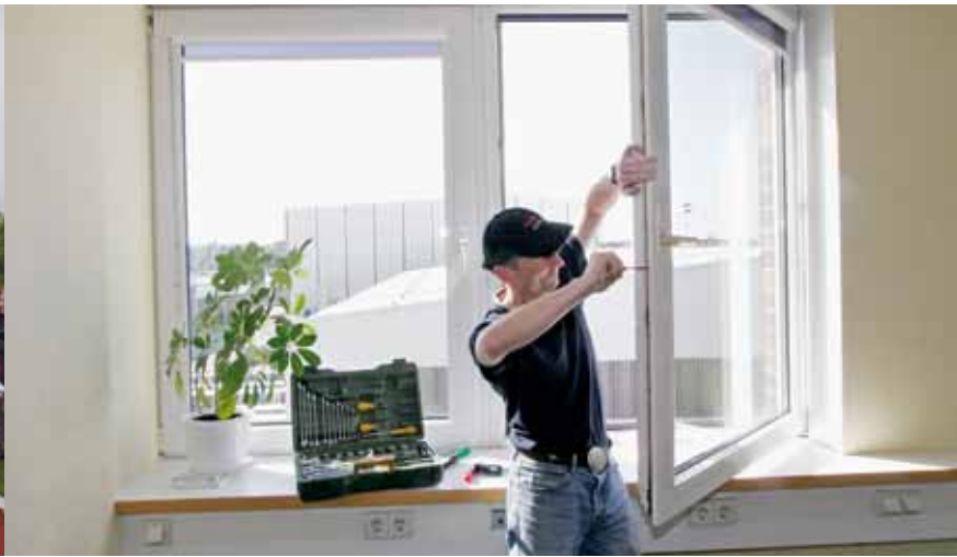
15.000 Wohnungen stattete Hamburg Airport in den vergangenen Jahren mit Schallschutzfenstern aus
