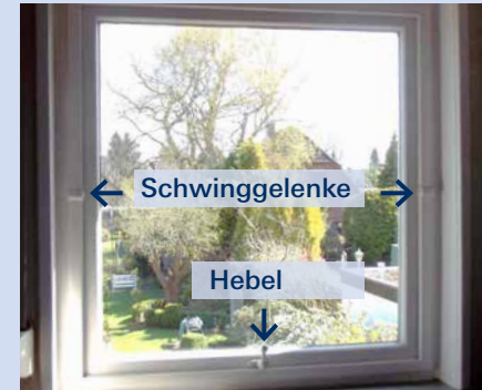
Bild 4: Schwingfenster ohne Dichtung
