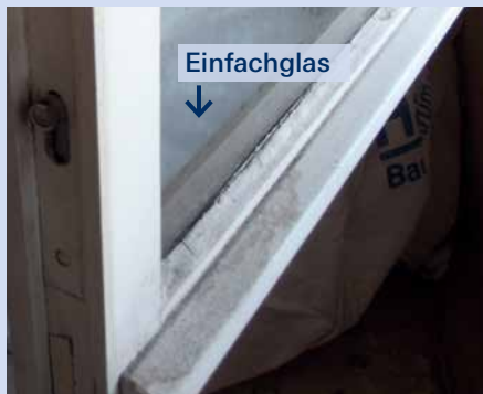
Bild 1: Fenster mit Einfachglas
